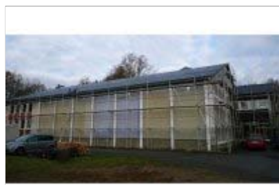
Bürgersolaranlage auf dem Dach der Florenburgschule
